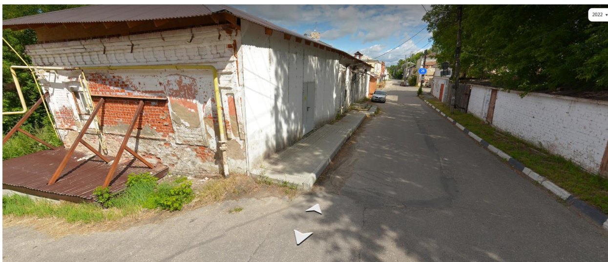
Ил. 19. Участок проектируемых работ. Дом 24. Дата съемки 2022 г. Участок 1. Вид с юга. Установлены контрфорсы. Источник:
